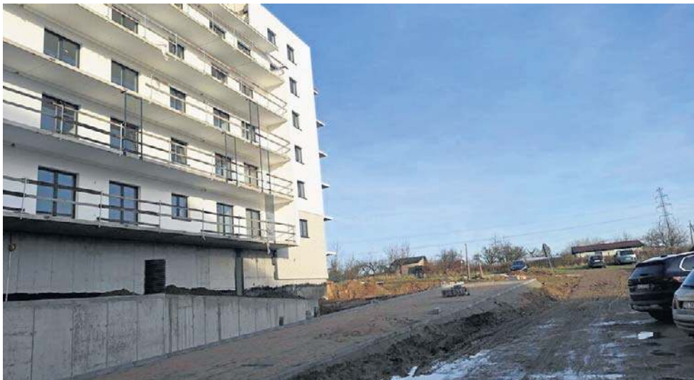
W budowanym właśnie bloku będzie można zamieszkać w drugim półroczu przyszłego roku
