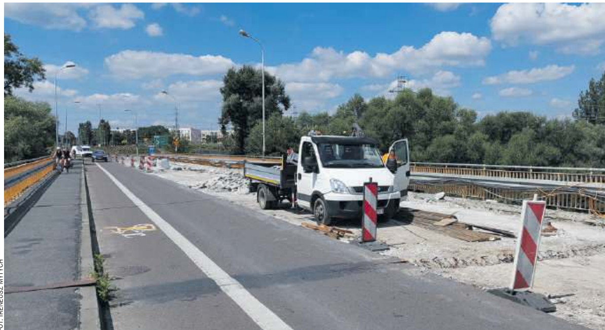
Po zakończeniu prac na połowie jezdni mostu, roboty rozpoczną się na drugiej części przeprawy. Przez cały ten czas obowiązuje tu ruch wahadłowy
