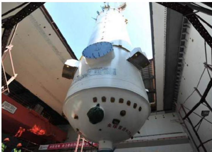
2. Instalacja komory chińskiego reaktora HTR-PM
