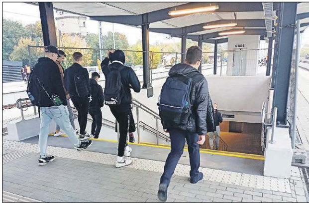
Przejście podziemne na białym dworcu zostało udostępnione w październiku. Na peronach wciąż trwają prace, związane z inwestycją
