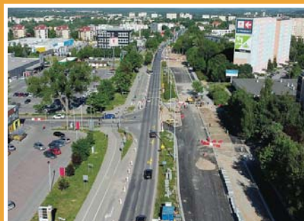
Remont ważnej ulicy w kierunku obwodnicy \4
