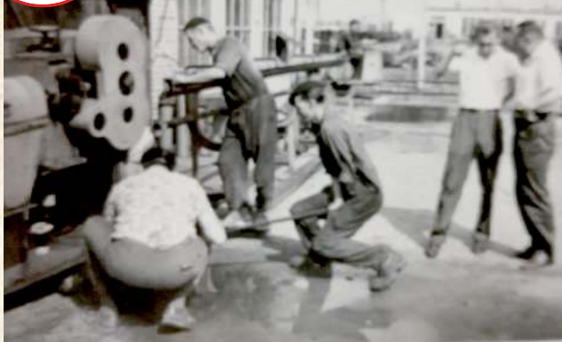
Na zdjęciu uwieczniono ustawianie maszyny do rozciągania drutów zbrojeniowych. Fotografia została wykonana w latach 70. ubiegłego wieku podczas budowy Zakładów Azotowych
