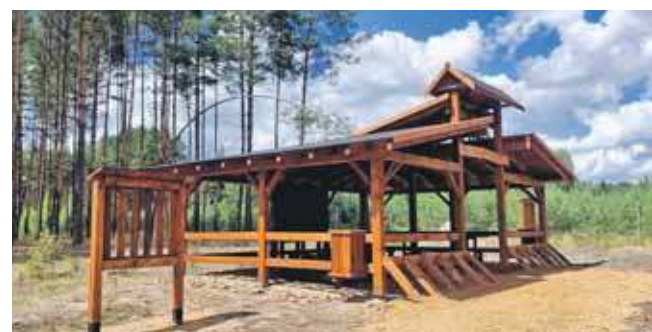
Stanica „Meandry Małej Panwi” została zaprojektowana na wzór sprawdzonych lokalizacji w Truszczy, Jędrysku oraz Zielonej
