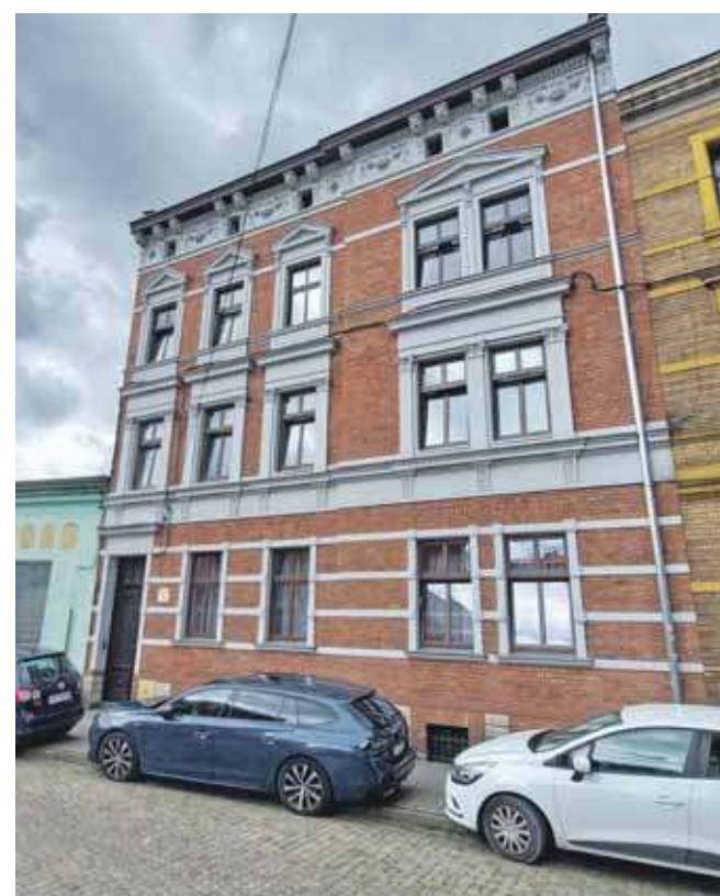
W kamienicy ma zostać zmodernizowana instalacja grzewcza
