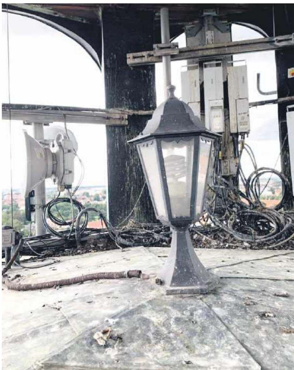
Tak wyglądało wnętrze ratuszowej wieży jeszcze parę tygodni temu - pełne ptasich odchodów i kłębowisk kabli...
