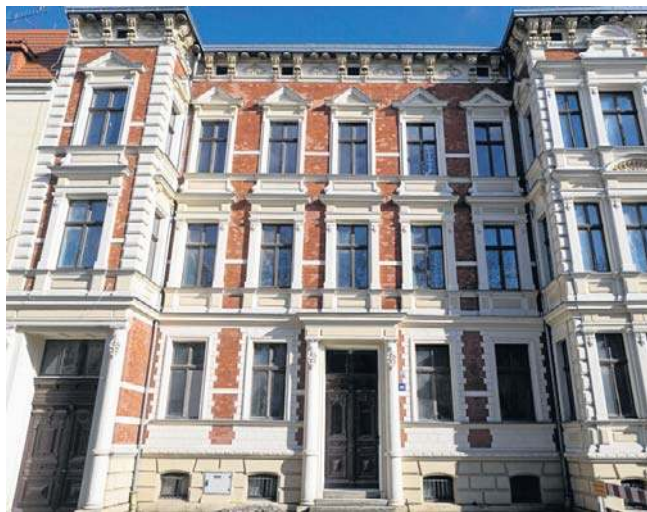
Nowa elewacja jednego z remontowanych budynków
