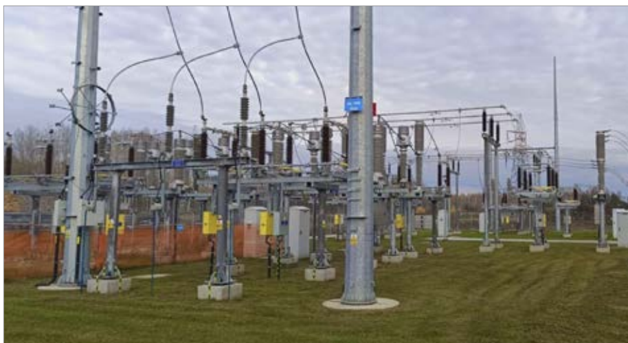
Rozbudowa i modernizowanie sieci dystrybucyjnych to kluczowe działania dla zapewnienia pewnych i stabilnych dostaw energii elektrycznej o właściwych parametrach. Pod koniec 2025 roku białostocki Oddział Spółki zakończył modernizację stacji 110/15 kV Polanka w Czarnej Białostockiej. Koszt inwestycji to ponad 18 mln zł. Źródło: PGE Dystrybucja
