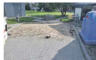
Prace rozpoczęły się od zerwania kostki betonowej przed wiatą śmietnikową
