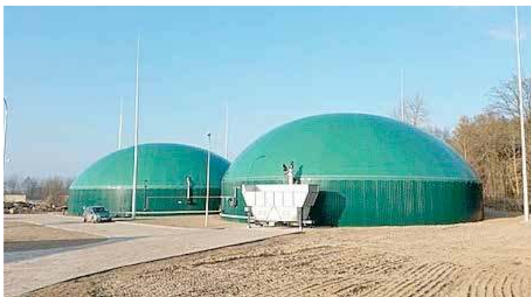
Widoczne na zdjęciu instalacje biogazowe zostały wybudowane m.in. w Świdwinie i Legnicy. Foto. Polskie Stowarzyszenie Producentów Biogazu
