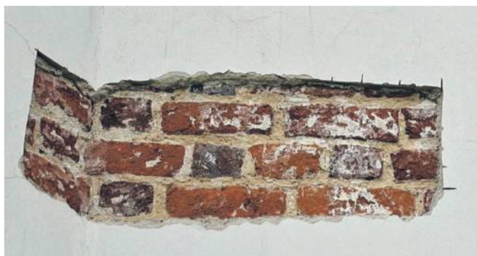
Najstarszy wątek z liceum dwuwozówkowym cegieł (tzw. wendyjskim lub słowiańskim) na wschodniej elewacji godzikowickiego kościoła
