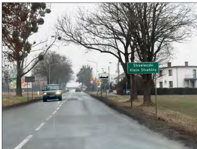
Droga wojewódzka 409 przejdzie kolejne remonty.
