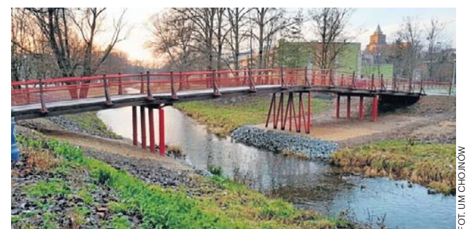
Nawierzchnia powstanie z desek kompozytowych
