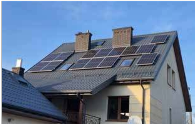
Instalacja fotowoltaiczna pozwala zaoszczędzić na rachunkach za prąd
