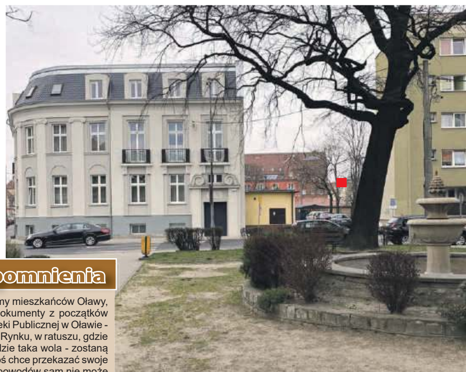
To samo miejsce na zdjęciu z 2022 roku - świeżo odnowiony budynek, zwany „okrągłakiem”, na wprost pięknie odnowiony portal drzewiowy widoczny na pierwszym zdjęciu, w miejscu ruin przedwojennego budynku dziś trochę w głębi stoi trafostacja
