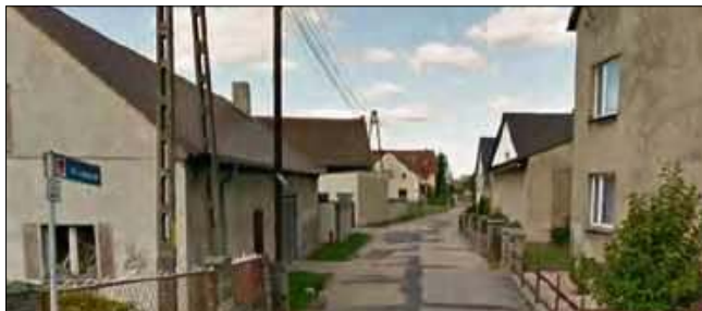
Przebudowa ul. Łącznej w Zielinie. Wartość zadania: 1 000 000 zł.
