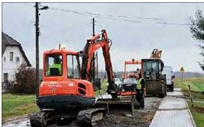
Budowa kanalizacji sanitarnej wraz z rozbudową sieci wodociągowej w Ścigowie. Wartość inwestycji: 6 567 865,23 zł.
