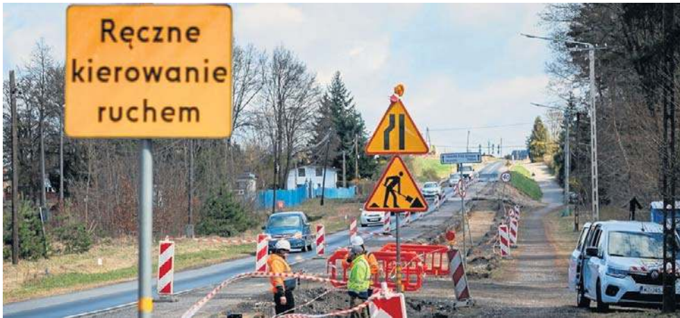
W Żołędowie trwa modernizacja drogi wojewódzkiej nr 244
