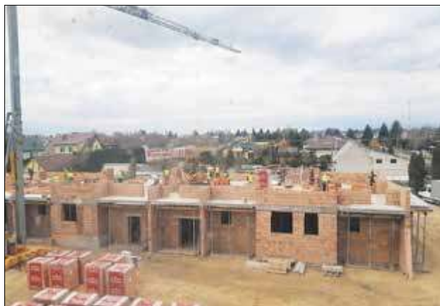
Trwa budowa bloku komunalnego w Terespolu przy ul. Piłsudskiego. Zakończenie inwestycji planowane jest na 30 listopada 2022 r.
