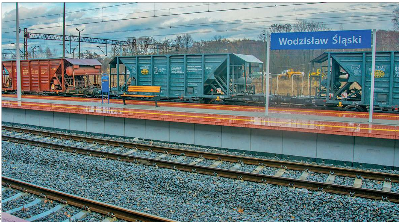
Nowy przystanek kolejowy w centrum Wodzisławia Śl. ma powstać do końca pierwszego kwartału 2024 roku. Na zdjęciu jeden z peronów wodzisławskiego dworca.
