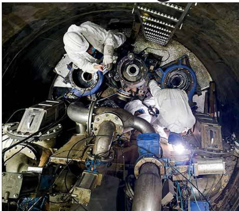
Ekipa naprawcza przy pracy
