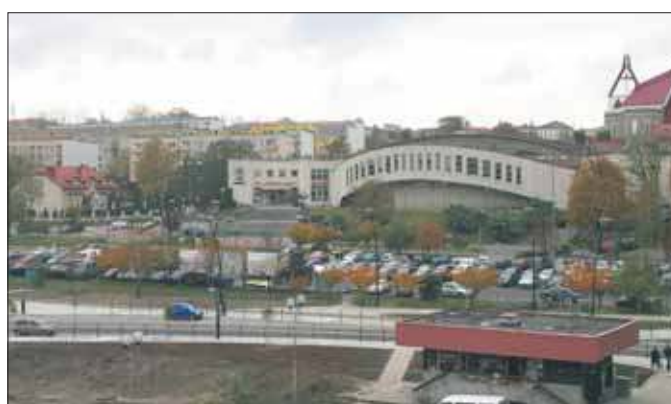
Po zakończeniu remontu hala zyska nową elewację
