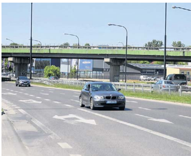
Szybkie naprawy jezdni zaplanowano m.in. na wiadukcie w rejonie Młyna Krauzego
