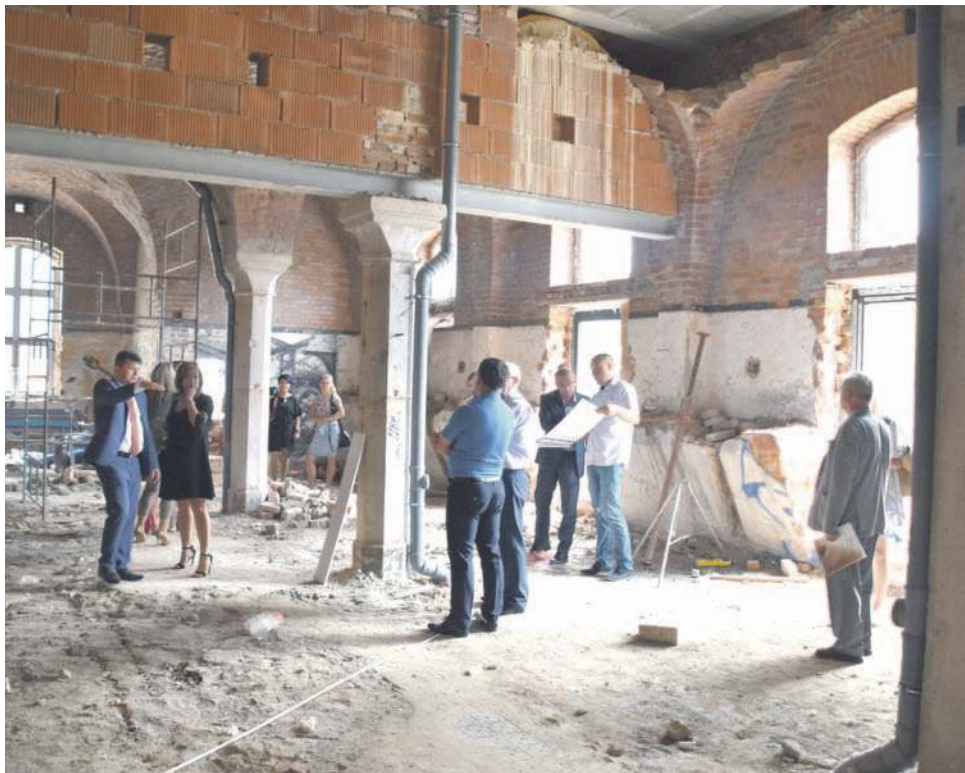
Prace już się rozpoczęły. Na początku roku to miejsce zupełnie się zmieni
