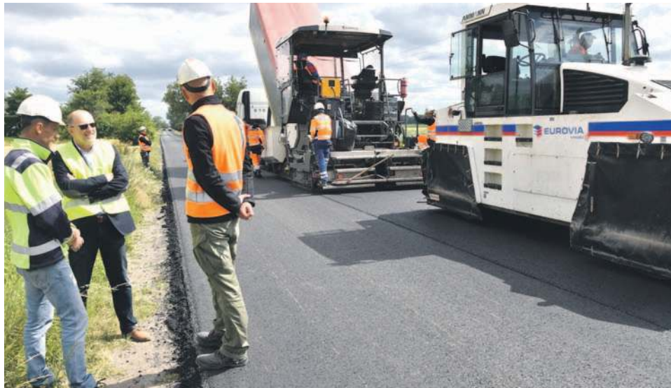
Na początku lipca starosta Zdzisław Brezdeń wziął udział w przeglądzie inwestycji drogowych, realizowanych w powiecie olawskim. Na zdjęciu odcinek remontowanej drogi powiatowej nr 1565D, na odcinku od Jaczkowic przez Siecieborowice do granicy powiatu
