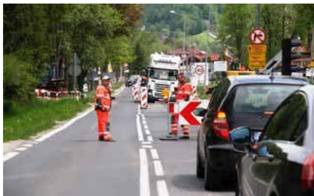
Ruszył remont drogi wojewódzkiej w Krościenku.
