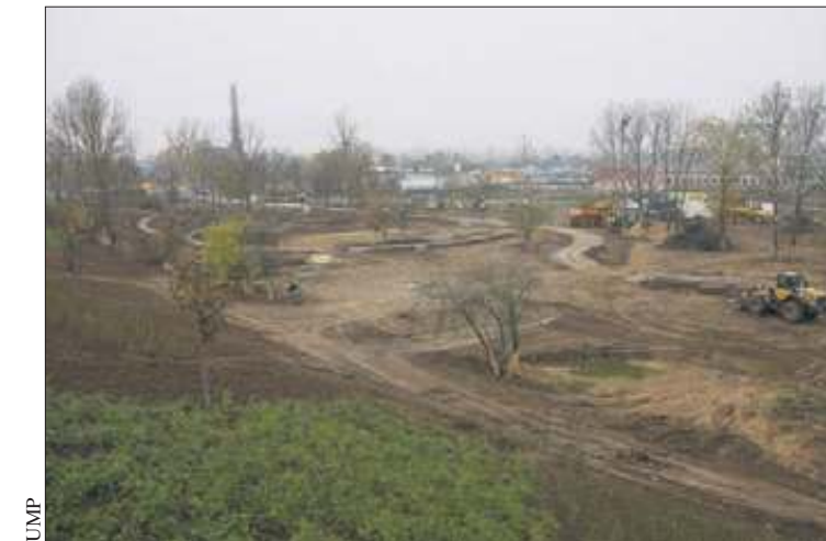
Już widać zarys nowych alejek parkowych na placu Mościckiego
