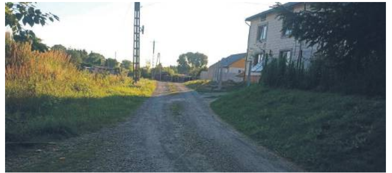
Szutrowa droga po deszczu zamienia się w grzęzawisko, w czasie suszy unoszą się z niej kłęby pyłu
