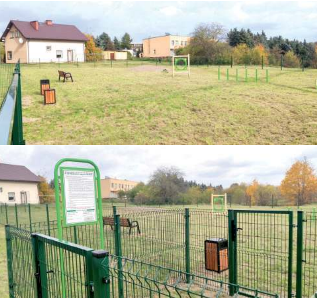
W pierwszym etapie budowy wybiegu dla psów w Łęcznej teren ogrodzono i ustawiono pierwsze urządzenia, w przyszłości pojawią się kolejne
