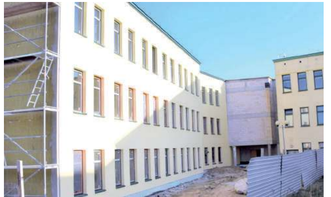
Tymczasem w Łęcznej nowe skrzydło szpitala ma już elewację od strony zachodniej
