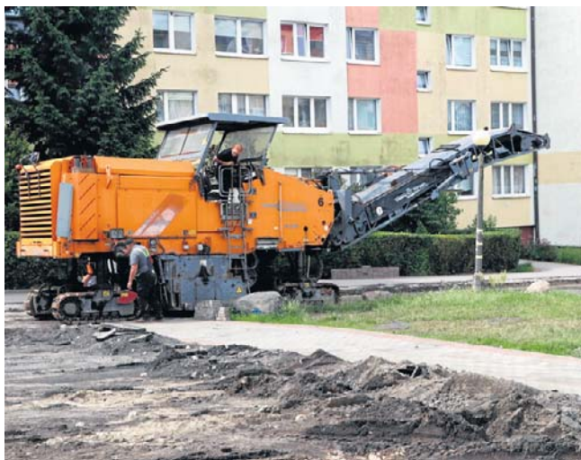
Stara asfaltowa nawierzchnia została sfrezowana. Nowa wykonana zostanie z kostki betonowej
