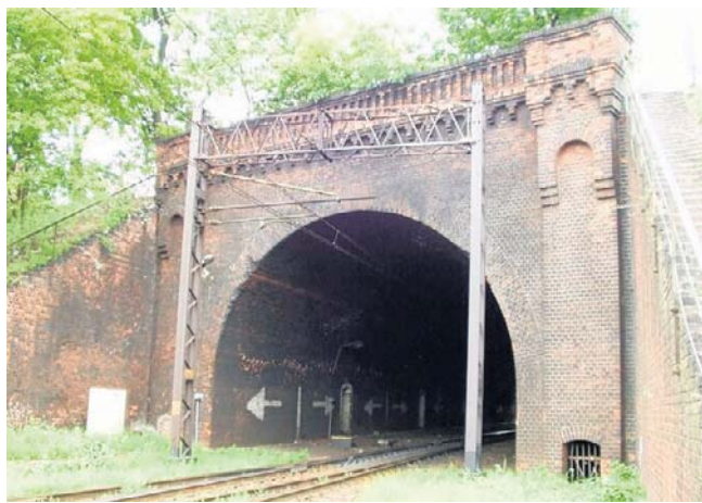
Zbudowana w latach 80. XIX wieku Brama Kolejowa jest jedynym wciąż czynnym tego typu obiektem w Polsce
