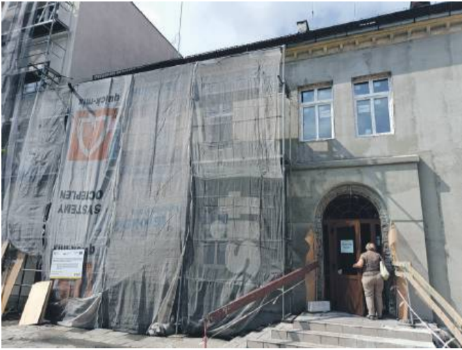
Termomodernizacja urzędu gminy w Borowie będzie kosztować prawie 3,3 mln zł
