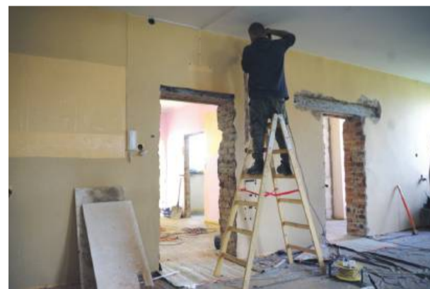
Trwają prace związane z adaptacją pomieszczeń w drugiej części budynku. Fot. Jakub Olejnik
