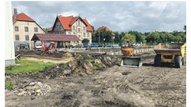
Trwa kompleksowa przebudowa boiska sportowego w Borowie. W ostatnim czasie wykonano fundamenty pod budowę wiaty rekreacyjnej. W tle widać też nową wiatę
