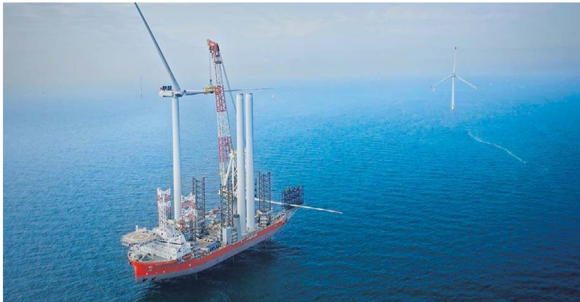
Stawianie siłowni wiatrowych na farmie Baltic Power
