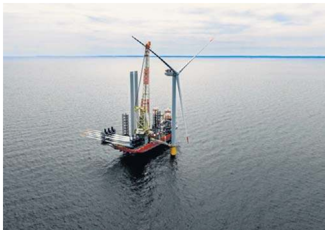
Osadzane monopali w dnie morskim umożliwia pływający dźwig instalacyjny
