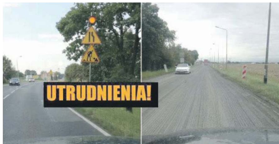
Na Opolskiej wprowadzono odpowiednie oznakowanie. Już część nawierzchni została zdjęta, prace idą szybko
