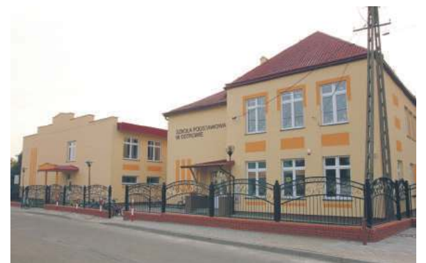
Szkoła w Ostrowie po termomodernizacji.
