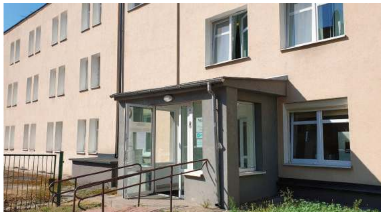
Jeszcze w tym roku do przychodni specjalistycznej SP ZOZ trafi nowoczesny sprzęt medyczny i wyposażenie. W przyszłym roku w budynku zostanie zainstalowana winda, a znajdujące się w niej poradnie przejdą gruntowny remont
