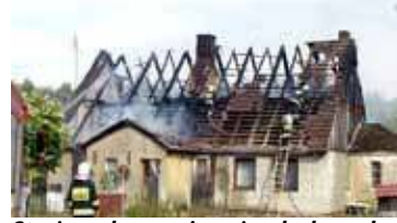
Strażacy dogaszają pożar dachu na budynku w Zakłodzie
