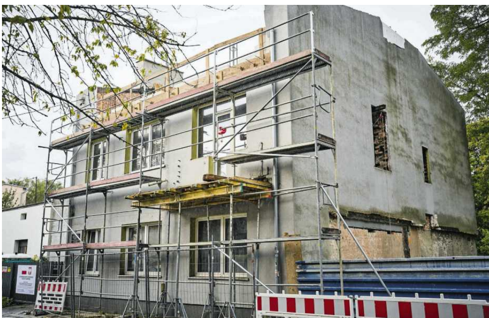
• Przebudowa budynku przy ul. Przemysłowej 34 FOT. MARCIN STĘPIEŃ / AGENCJA WYBORCZA.PL
