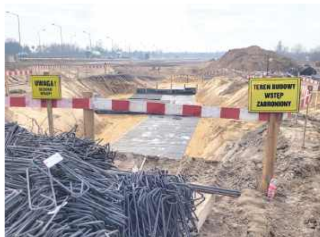
Wykopy pod fundamenty obiektów mostowych
