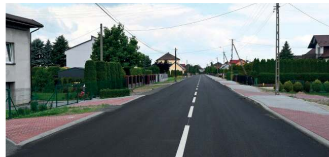
Ul. Nadwiślańska w Gromcu po modernizacji
