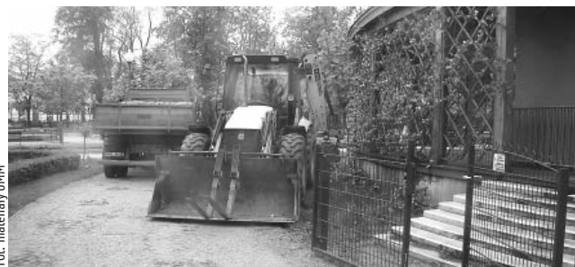
Ruszyły prace przy przebudowie estrady
