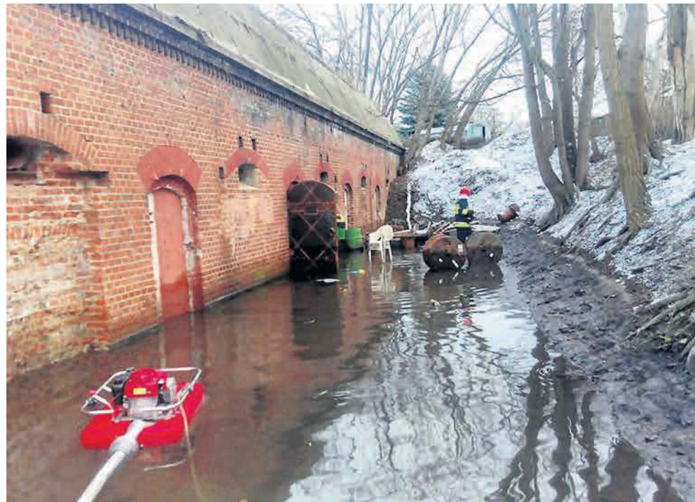
Dopiero sprzęt straży pożarnej poradził sobie z wypompowaniem wody ze schronu
