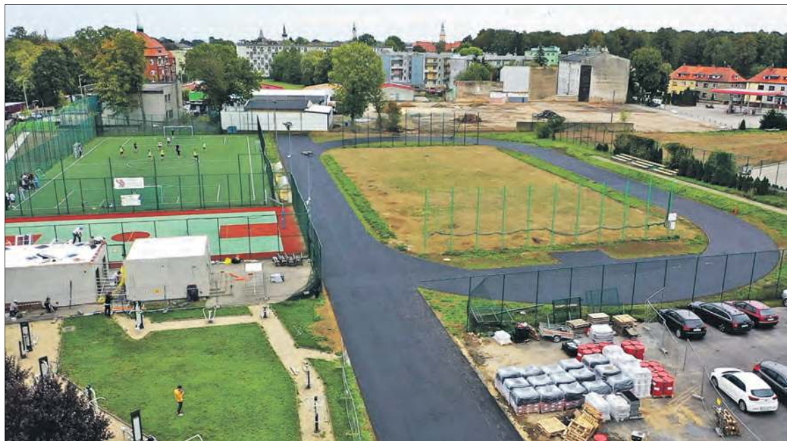
Stan prac remontowych w połowie października
