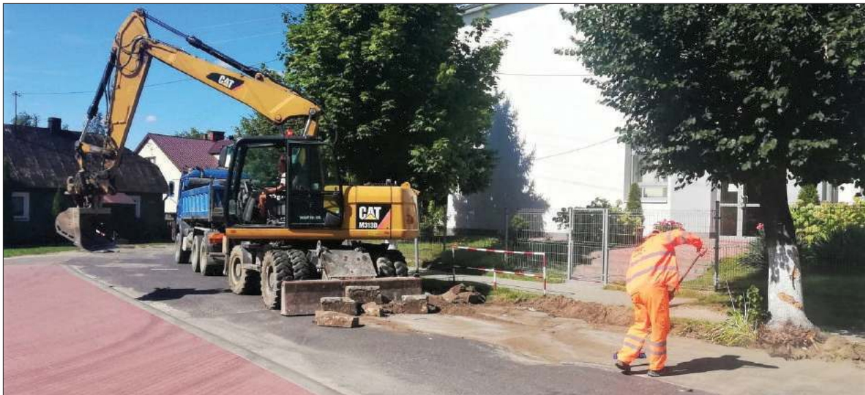
Pracownicy PRD z Lubartowa, które wygrało przetarg, weszli na plac budowy w czwartek. Póki co zajęli się przebudową chodnika przy ulicy Rynek
