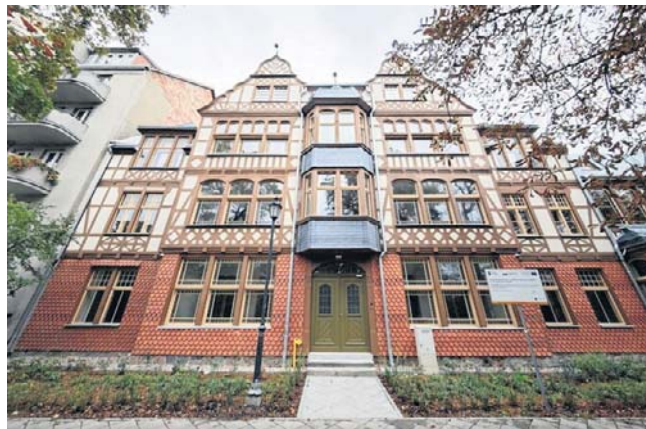
Tak wygląda kamienica przy Bydgoskiej 50-52 po remoncie
