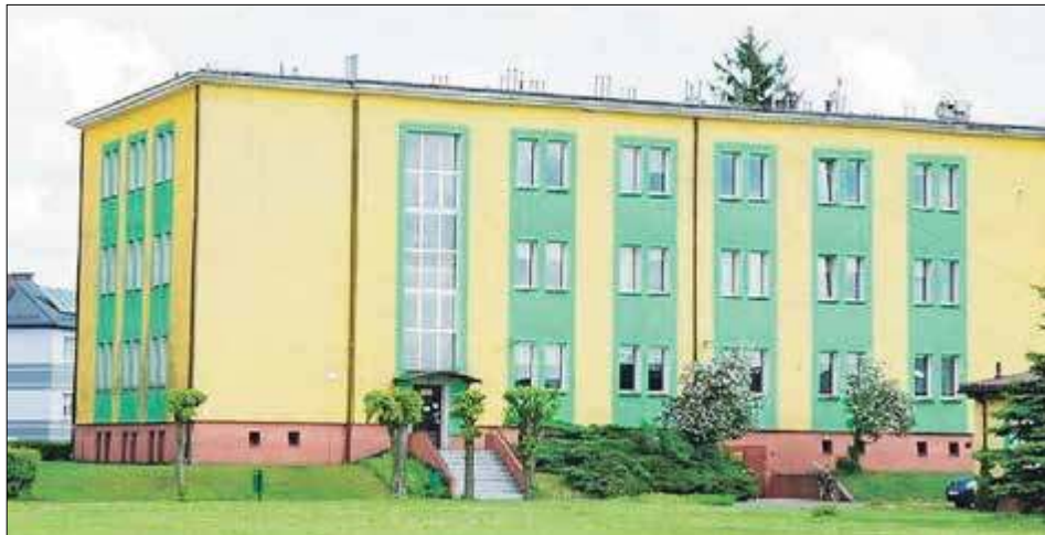
Około 200 mieszkańców podpisało apel, w którym sprzeciwiają się budowie masztu na budynku internatu ZSE
