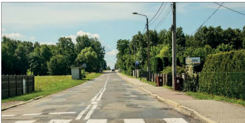
Przewidywany termin ukończenia przebudowy ul. Czarnieckiego wraz z robotami towarzyszącymi to koniec 2023 r., zaś szacowany koszt inwestycji to 14,3 mln zł
