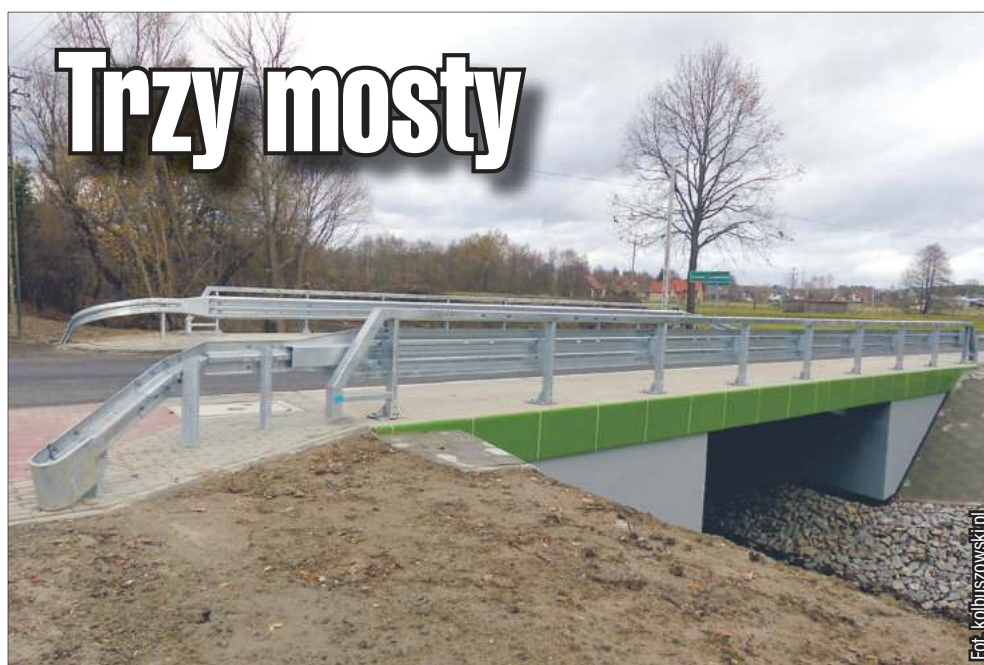
Zrealizowano również inne prace, takie jak położenie nowego dywanika asfaltowego o długości 190 metrów oraz nowego chodnika o długości 232 metrów.
