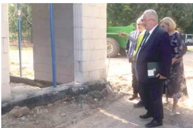
Minister Czesław Siekierski wraz z dyrektorką szkoły Agnieszką Piekarską i zaproszonymi gośćmi odwiedzili plac budowy Branżowego Centrum Umiejętności, w którym swoje miejsce znajdą między innymi sale konferencyjne i laboratorium
