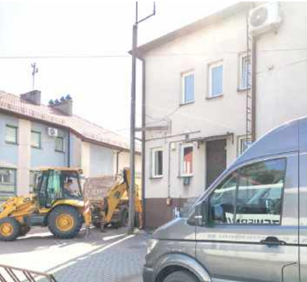
Ruszyła termomodernizacja budynku urzędu miasta
