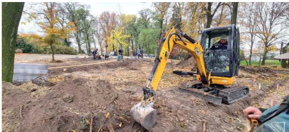
Prace już trwają, powinny się zakończyć 10 grudnia
