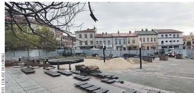
Trwa II etap przebudowy Rynku w Chrzanowie
