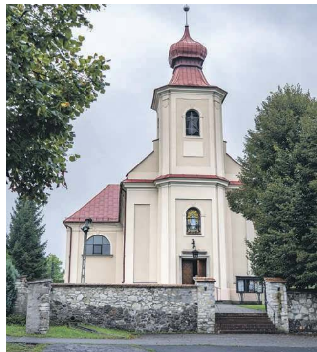
Fasada z głównymi drzwiami i górującą wieżą
