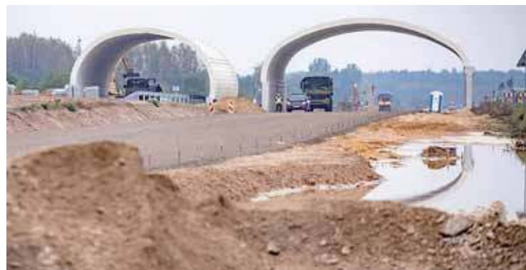
Na łączącym ok. 35 km odcinku powstanie około 40 obiektów inżynierskich, głównie wiaduktów
